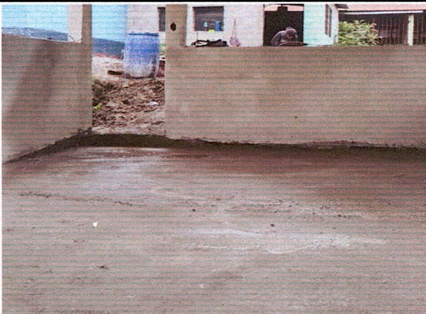
Foto 3: Proceso de mejoramiento de losa de piso.
