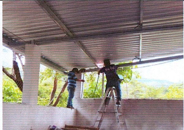
Foto 2: Proceso de mejoramiento de la estructura tipo portico para cocina.
